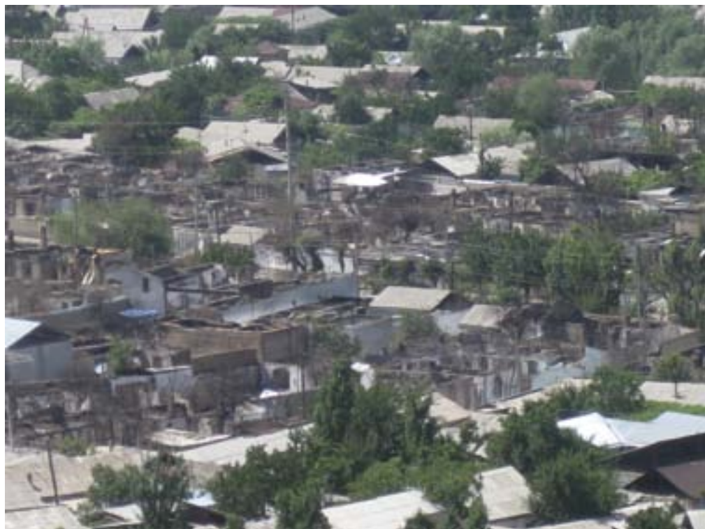
Зона разрушений на ул. Навои. Вид с Сулейман-Тоо.
